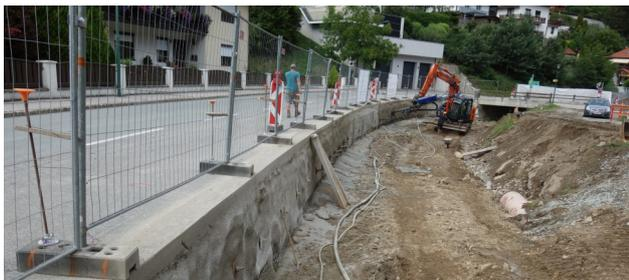
Im August begann die Wildbachverbauung mit den Baumaßnahmen zur Sanierung der desolaten Ufermauer. In der ersten Bauetappe wurden die desolaten Mauer abgebrochen und die Böschung mit Spritzbeton abgesichert sowie stabilisiert. Im nächsten Schritt wird eine ausreichend dimensionierte Stahlbetonmauer vorgesetzt.
