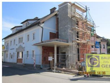
Ansicht mit dem Lift für einen barrierefreien Zugang.
