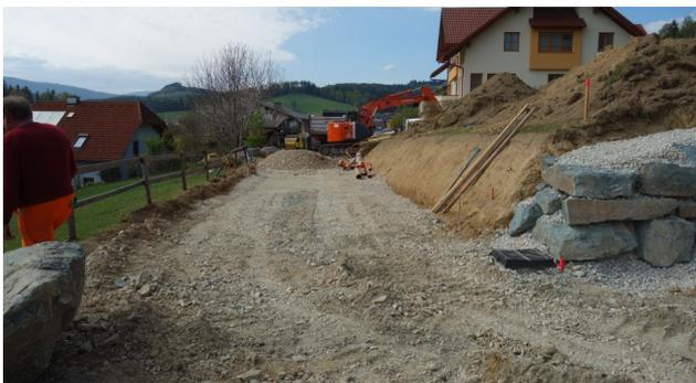
In der Kurzen Gasse erfolgte die Erweiterung der Wasser- und Kanalleitung durch die Firma Klöcher Bau GesmbH aus Hartberg. Ebenfalls errichtet wurde der Unterbau für die Straße sowie ein Umkehrplatz.
